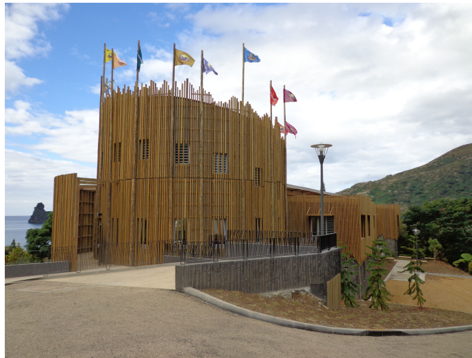
Bardage résille de la mairie de Hienghène – Réalisation : Les Charpentiers du Nord - Nouvelle-Calédonie © Henry Séchet, Scierie de Netchaot
